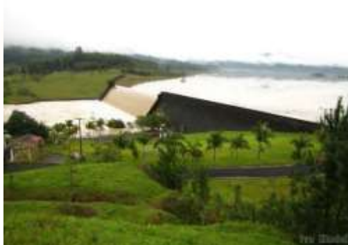
Figura 68 – Vertedouro da Barragem Oeste antes da sobrelevação – H035.
