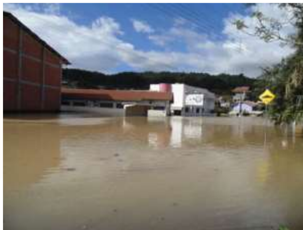
Figura 214 – Inundação Ocorrida em Taió em 23 de setembro de 2013.
