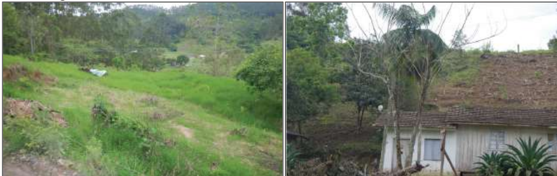
Figura 224 - Setor de Risco 03, identificado na Localidade de Tifa Eitz.
