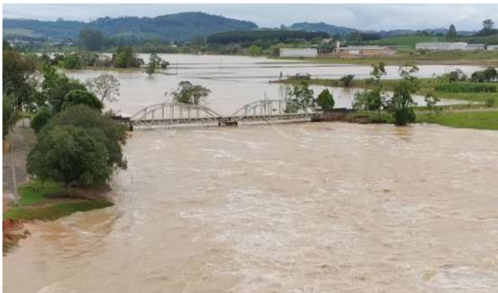
Figura 69 – Ponte Barragem Oeste – H061.
