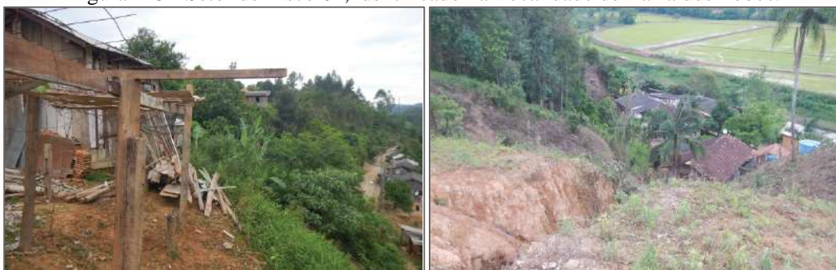
Figura 223 - Setor de Risco 02, identificado na Localidade de Barra dos Lobos.
