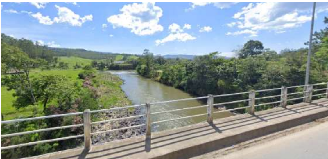
Figura 30 - Vista jusante do Rio Itajaí do Oeste – Ponte Passo Manso – 30/10/2019
