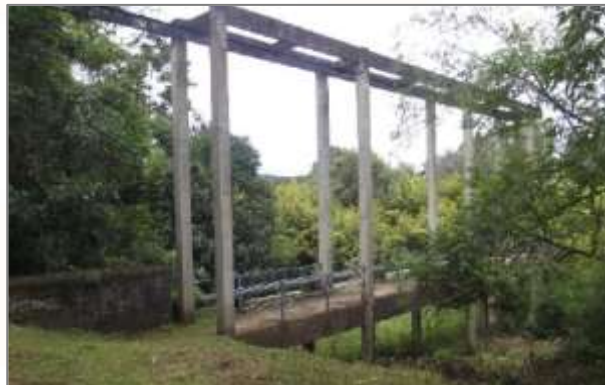
Figura 230– Ponto Superficial de Captação de Água – Perímetro Urbano da Sede.
