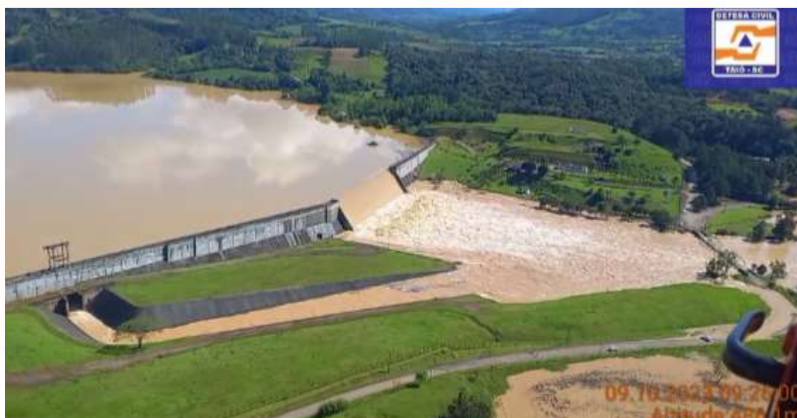
Figura 70 – Vertedouro após a sobrelevação.
