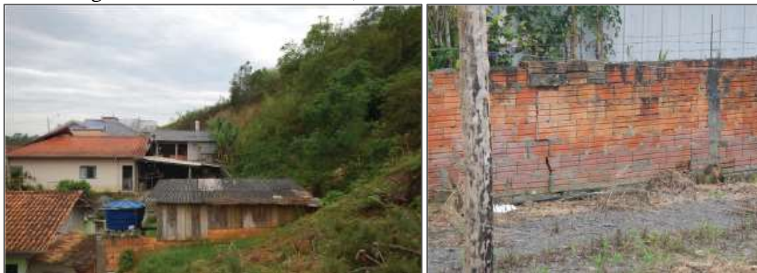
Figura 225 - Setor de Risco 04, identificado no Bairro Vila Mariana.
