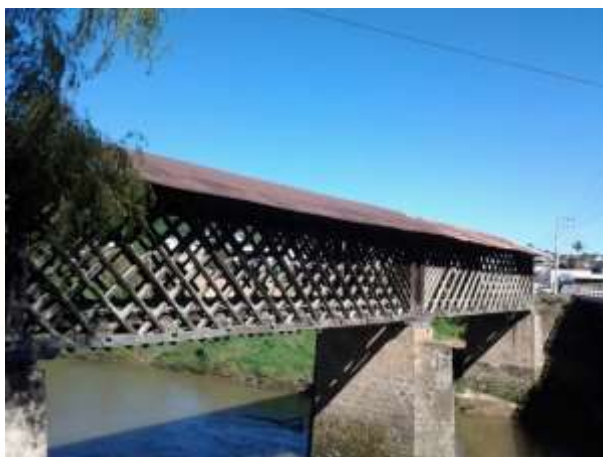
Figura 51 - Ponte Roberto Machado.
