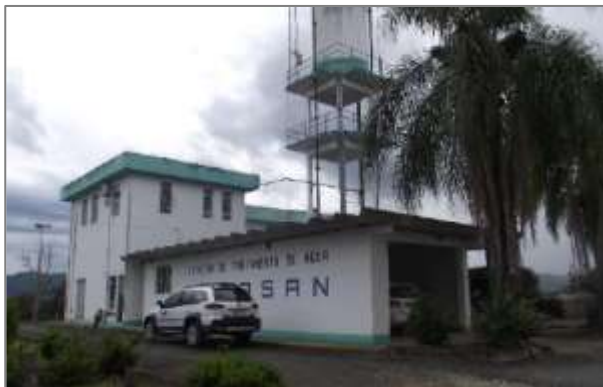
Figura 231 – Estrutura Física da ETA do Perímetro Urbano da Sede de Taió.
