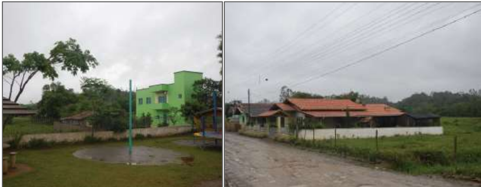
Figura 228 - Setor de Risco 07, identificado na Localidade de Ribeirão Pinheiro.
